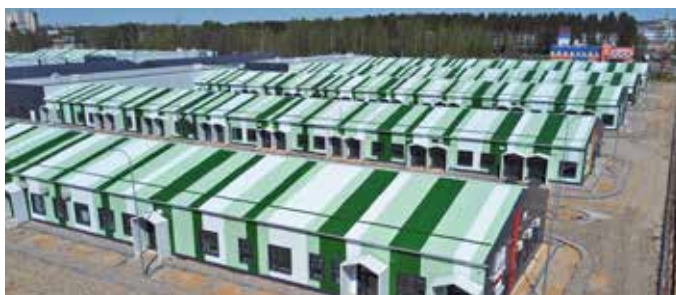
Инфекционный госпиталь, площадь 27 тыс. м 2 , г. Иваново
