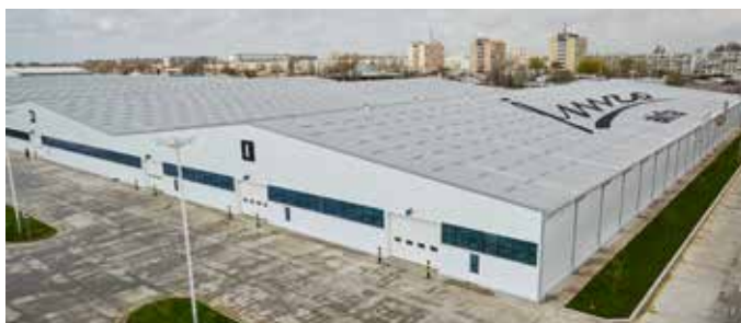
Фабрика оконных конструкций, площадь 76 тыс. м 2 , Узбекистан
