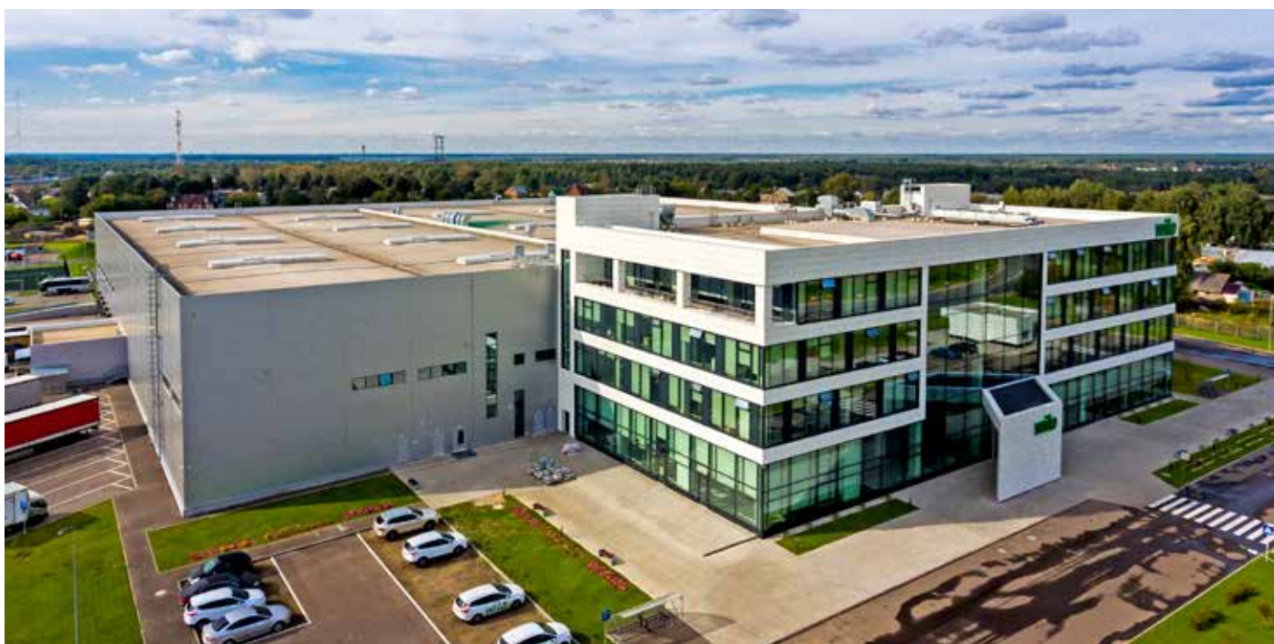
Производственно-складской корпус, площадь 17 500 м 2 , Московская обл.
