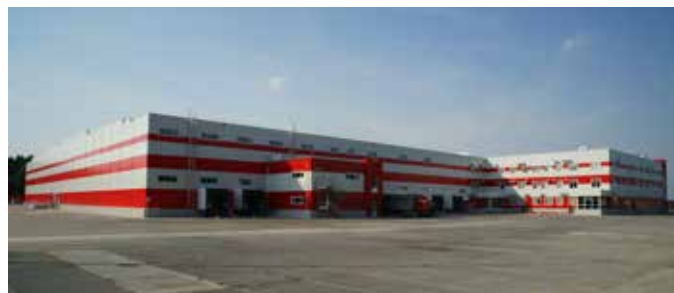
Распределительный центр «Магнит», площадь 19 700 м 2 , Смоленская обл.
