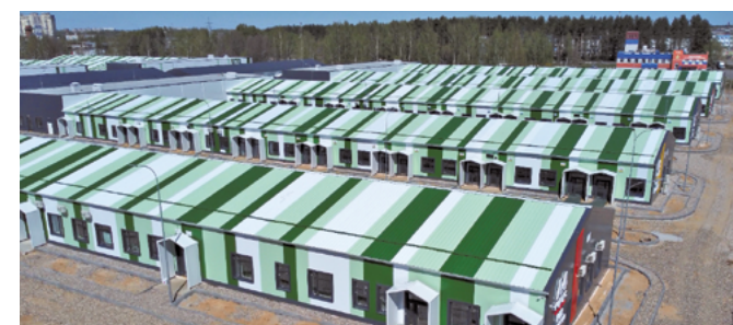
Инфекционный госпиталь, площадь 27 тыс. м 2 , г. Иваново
