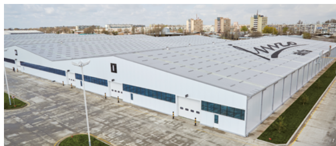
Фабрика оконных конструкций, площадь 76 тыс. м 2 , Узбекистан
