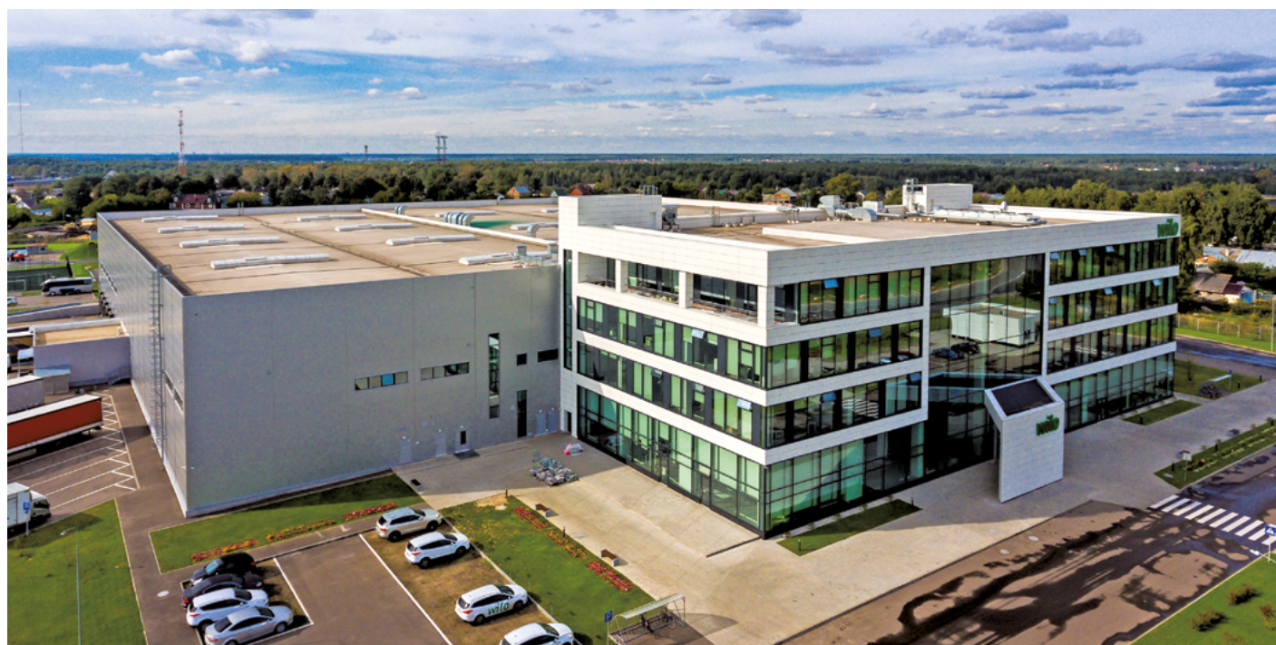
Производственно-складской корпус, площадь 17 500 м 2 , Московская обл.
