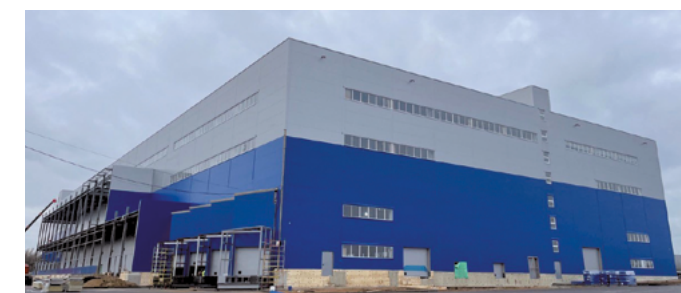
Производственный комплекс, площадь 20 тыс. м 2 , г. Обнинск
