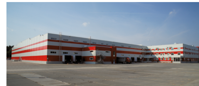
Распределительный центр «Магнит», площадь 19 700 м 2 , Смоленская обл.
